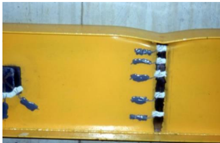
(a) Viga V1
